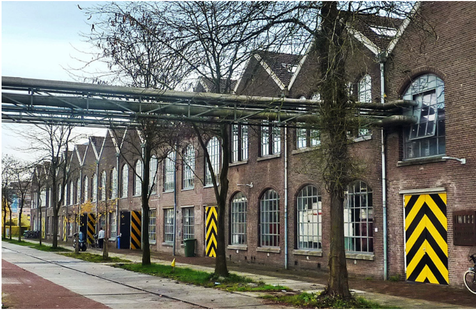
1 De noordgevel van het hoofdgebouw van de wagenwerkplaats in 2013
