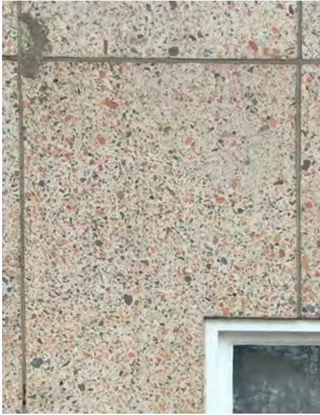
Detail gevelplaat station Hengelo, oostzijde, met toeslagmaterialen
