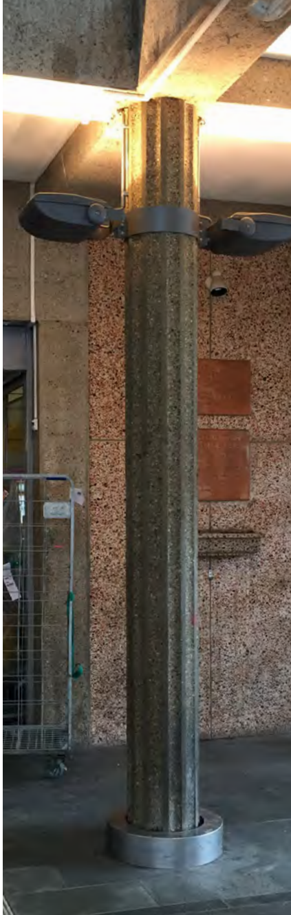
Gecanneleerde zuil station Hengelo, binnen en buiten
