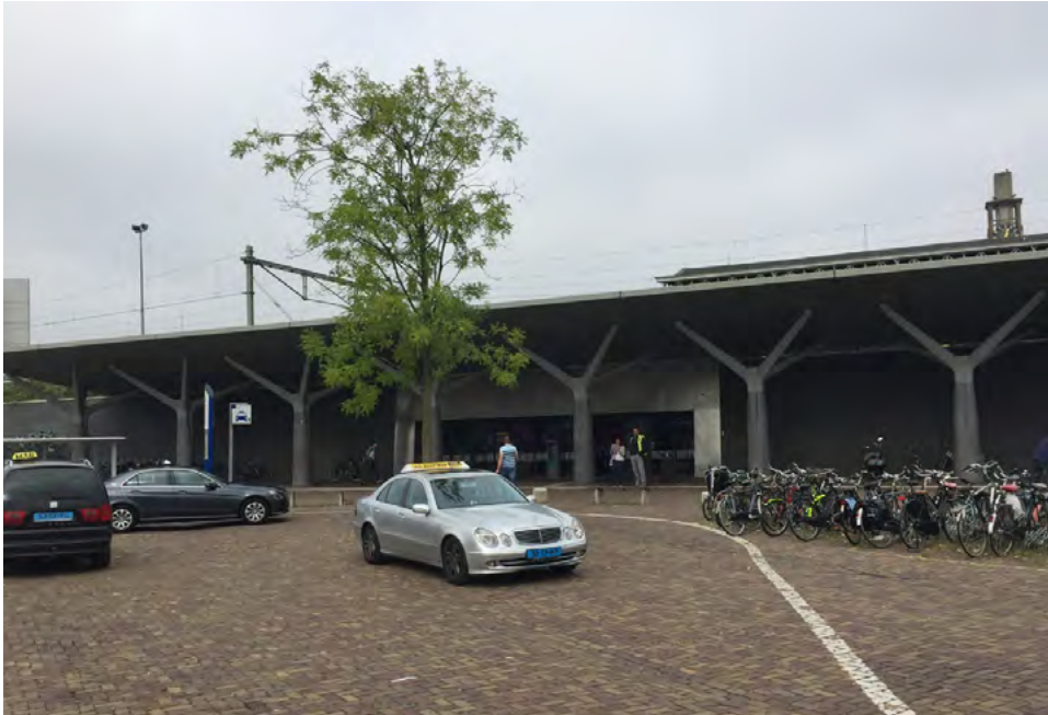
Huidige situatie entree zuidzijde
