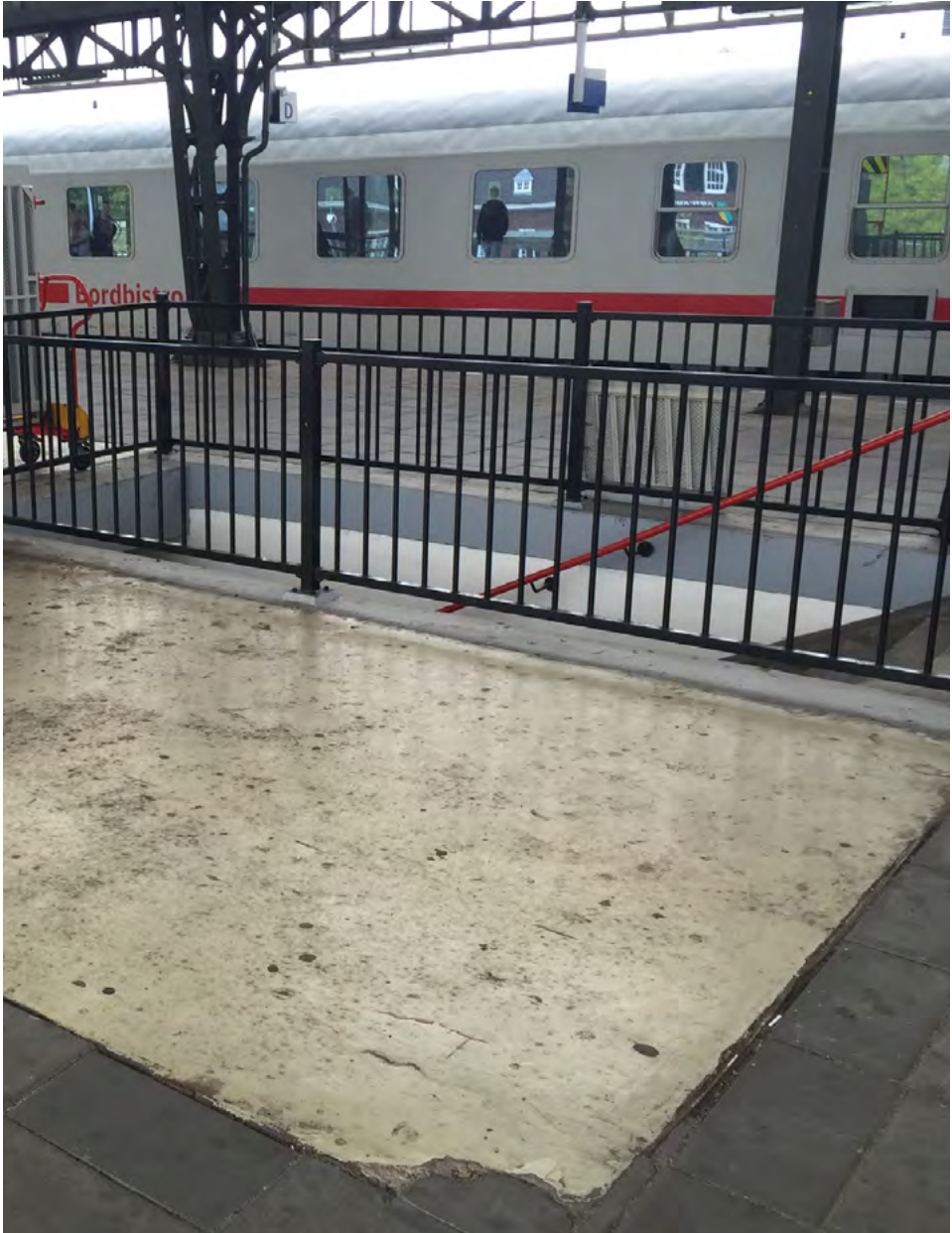
De toegangstrap vormde in de vooroorlogse situatie de entree naar het perroneiland (tegenwoordig deels afgedekt met een betonplaat)
