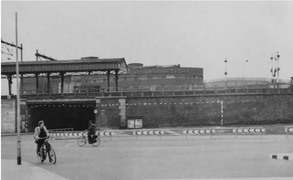
Het vooroorlogse viaduct richting de Spoorstraat vanuit het noordelijke deel van de stad met de Industriestraat in het zuiden
