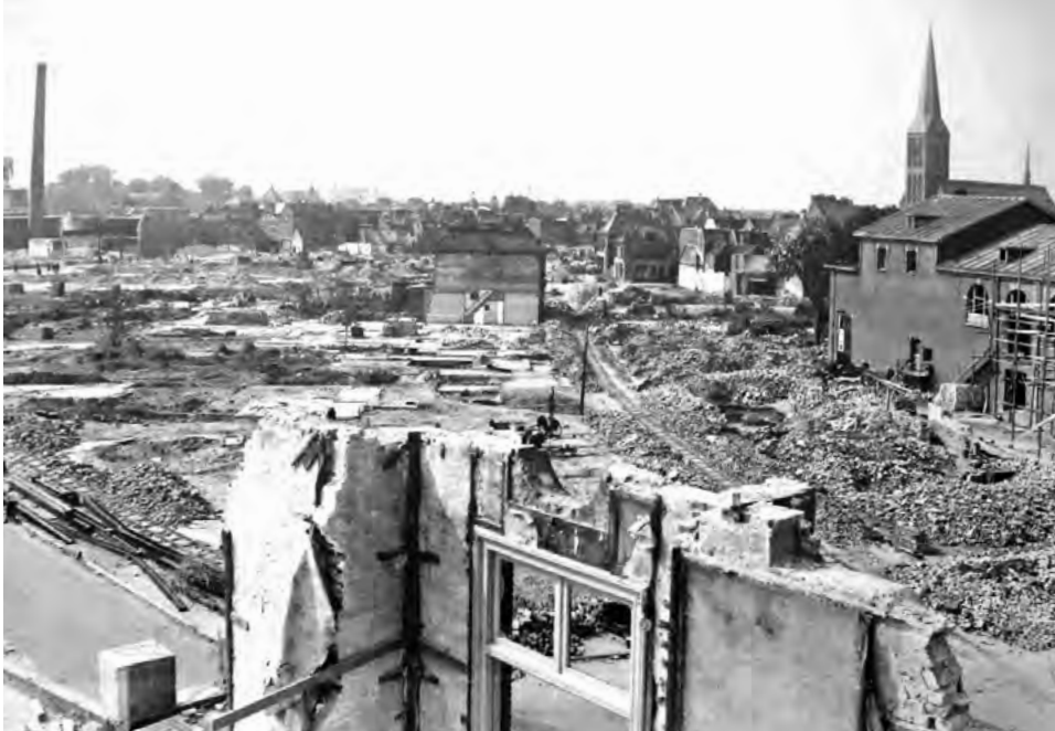
Vernielingen na het bombardement, gezien vanaf het ernstig beschadigde station, 1944
