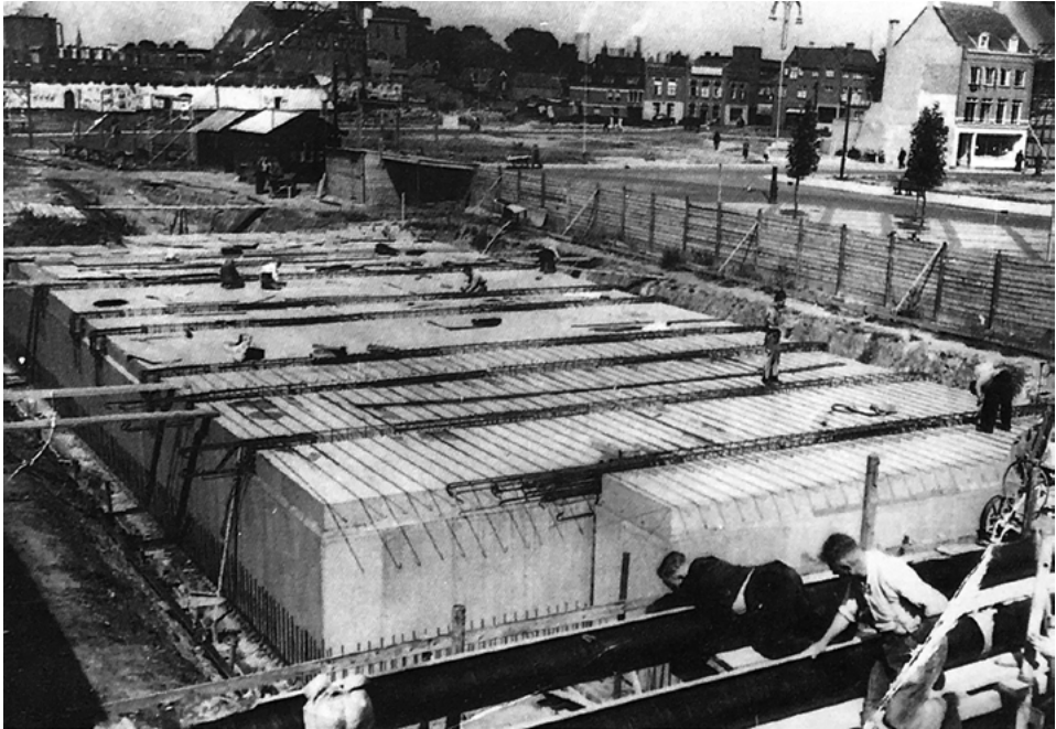
Betonbekisting van het nieuwe station, 1950
