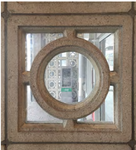
Detail claustra station Hengelo, voorgevel
