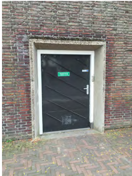
Toegang en entree in de keerwand naar de personeelsfietsenstalling en locker-room voor het spoorpersoneel en diensttoegang tot het perron
