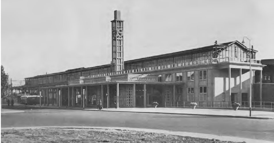
Station Hengelo, gezien vanaf het stationsplein
