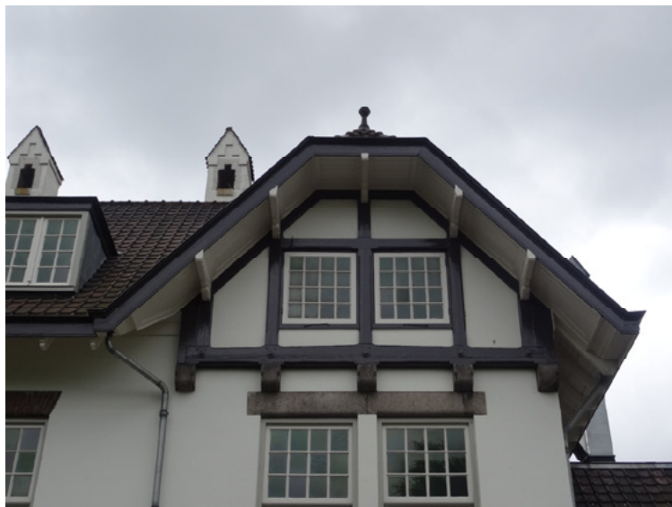
Afb. 5.33 De vakwerkconstructie rust op granieten consoles. Hier de westelijke topgevel aan de voorzijde.
