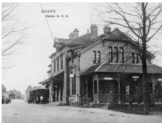
Afb. 5.21 Station Baarn-buurtstation, gebouwd 1897 door J.F. Klinkhamer. Het gebouw heeft een herkenbaar stationskarakter, dat leunt op de bouwprincipes van de standaardstations.
