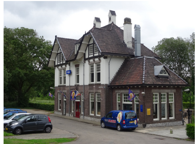
Afb. 2.8 De vier schoorstenen op het hoofddak. De voorste, metalen schoorsteen is rond 2004 bijgeplaatst.
