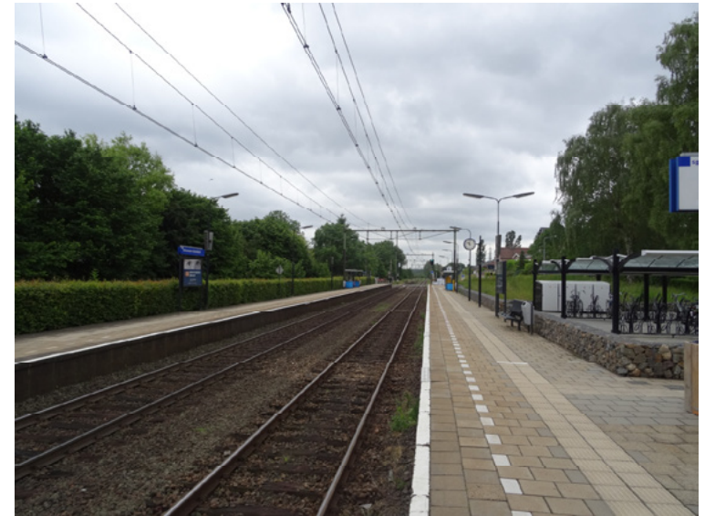
Afb. 4.11 De perrons, gezien vanaf het stationsgebouw naar het westen. Geheel in de verte zijn de abri's zichtbaar, waar zich de eigenlijke stationsfunctie afspeelt.
