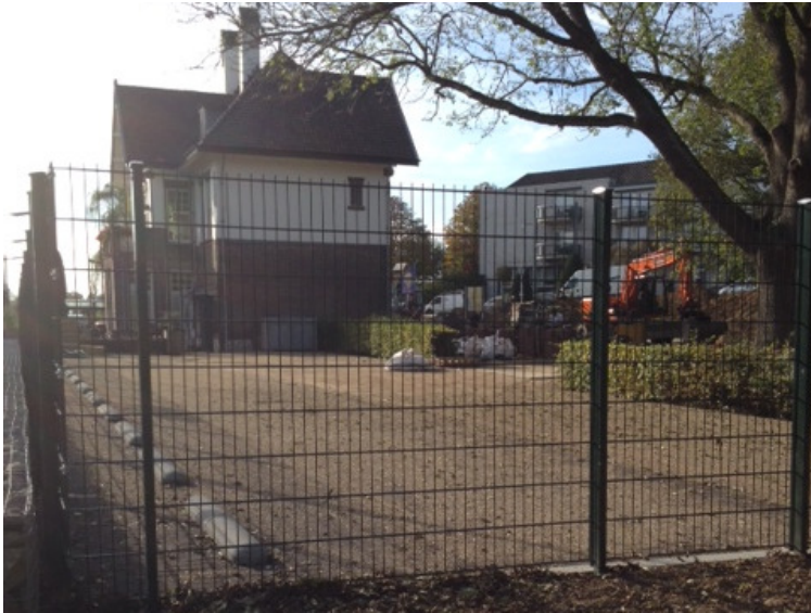
Afb. 4.17 Het nieuwe parkeerterrein ten oosten van het station, van het perron gescheiden door een nieuw hekwerk. Foto september 2014.
