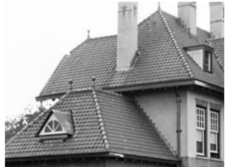
Afb. 5.31 De pironen op de dakhoeven van de mijnwerkerswachtkamer. Detail van foto, circa 1950.
