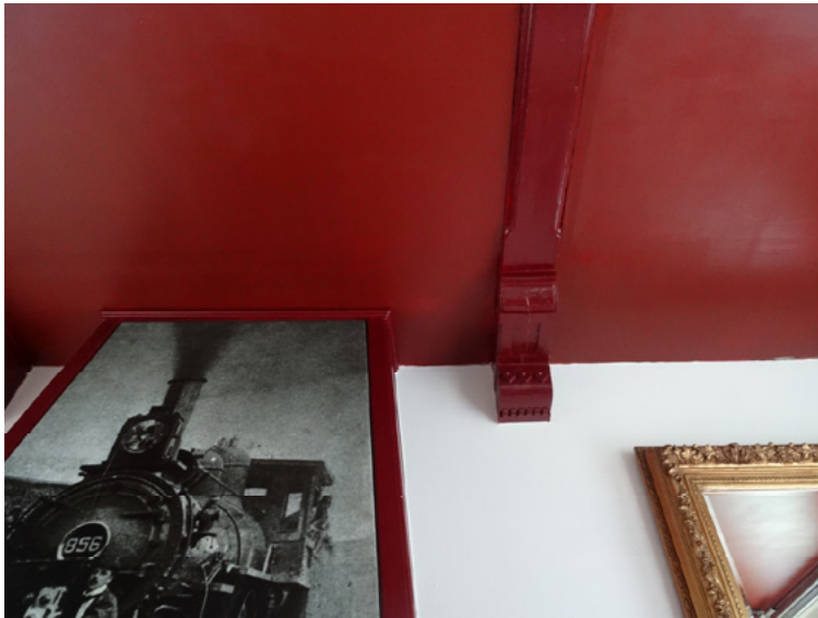
Afb. 5.43 Het vlakke plafond met versierde draagbalken in de wachtkamer 2e en 3e klasse. Plafond, balken, en schouwdelen zijn bij de laatste verbouwing rood geschilderd.
