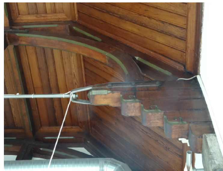
Afb. 5.41 Detail van opgewerkte, sierlijke dakconstructie in de mijnwerkerswachtkamer.
