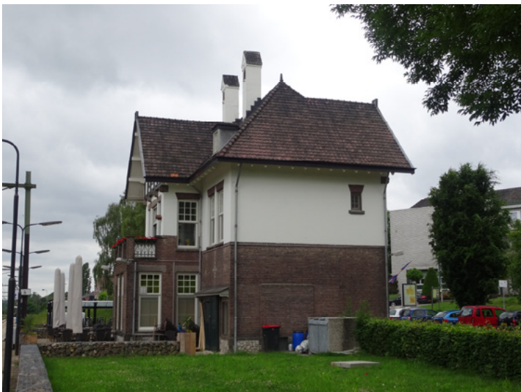
Afb. 2.7 De noordoostgevel van het gebouw, met op de begane grond de zichtbare gemetselde wand op de plaats van de vroegere schuifdeuren naar de goederenberplaats.
