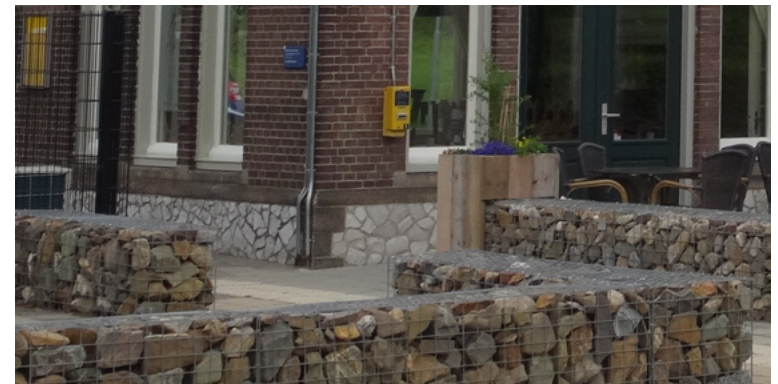
Afb. 4.9 De in 2011 geplaatste schanskorven met zwerfkeien refereren naar de natuurstenen-plint van het stationsgebouw.
