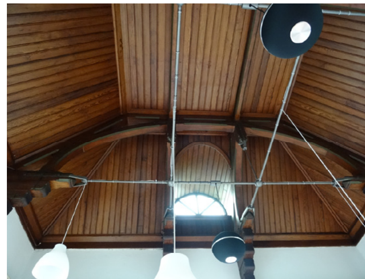
Afb. 5.42 De bijzondere dakconstructie in de mijnwerkerswachtkamer, met het halfronde venster aan de westzijde. In het houtwerk zijn links en rechts geen aanhalingen zichtbaar. Dit duidt erop dat hoogstwaarschijnlijk geen daklicht aanwezig is geweest aan die zijden, in tegenstelling tot wat het bestek aangeeft.
