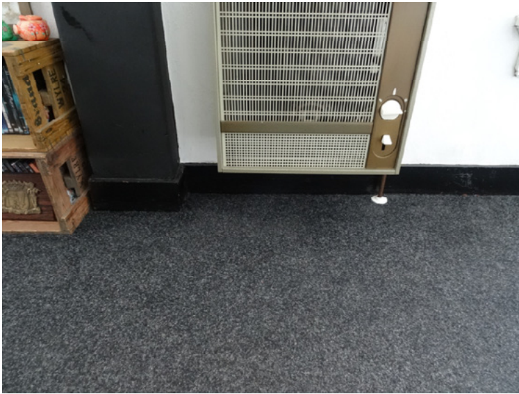
Afb. 5.50 Originele plinten langs de wanden.
