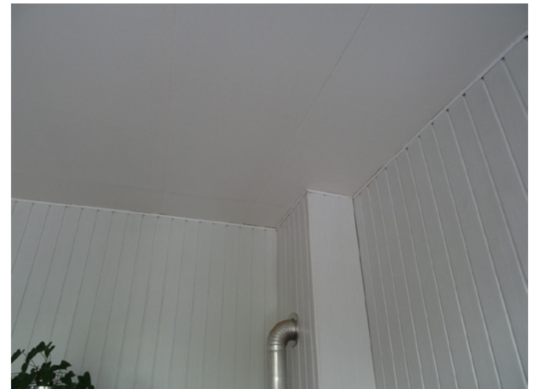
Afb. 2.11 De afwerking van de keuken in de bovenwoning sinds een latere verbouwing; schootjeswanden en een verlaagd plafond met boardplaten.
