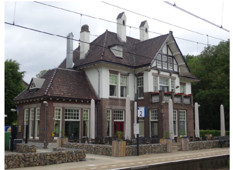
Afb. 2.10 Een deel van de buitenruimte is in gebruik als terras bij de brasserie. Deze functie geeft het stationsgebouw in het seizoen een zekere levendigheid.
