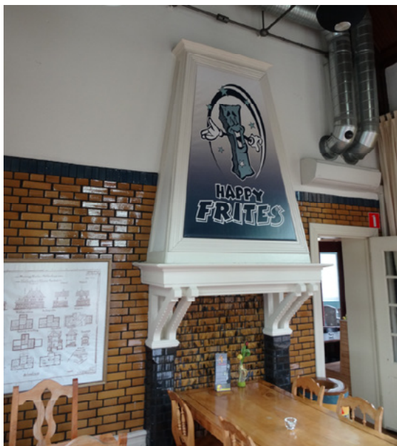
Afb. 5.38 De tegelwand en schouw in de mijnwerkerswachtkamer. De reclame op de schouw doet afbreuk aan het monumentale karakter van de mijnwerkerswachtkamer. Rechts de later gemaakte doorgang naar de wachtkamer 2e en 3e klasse. Links van de schouw hangt ter decoratie een kopie van de bestekstekening van het station.
