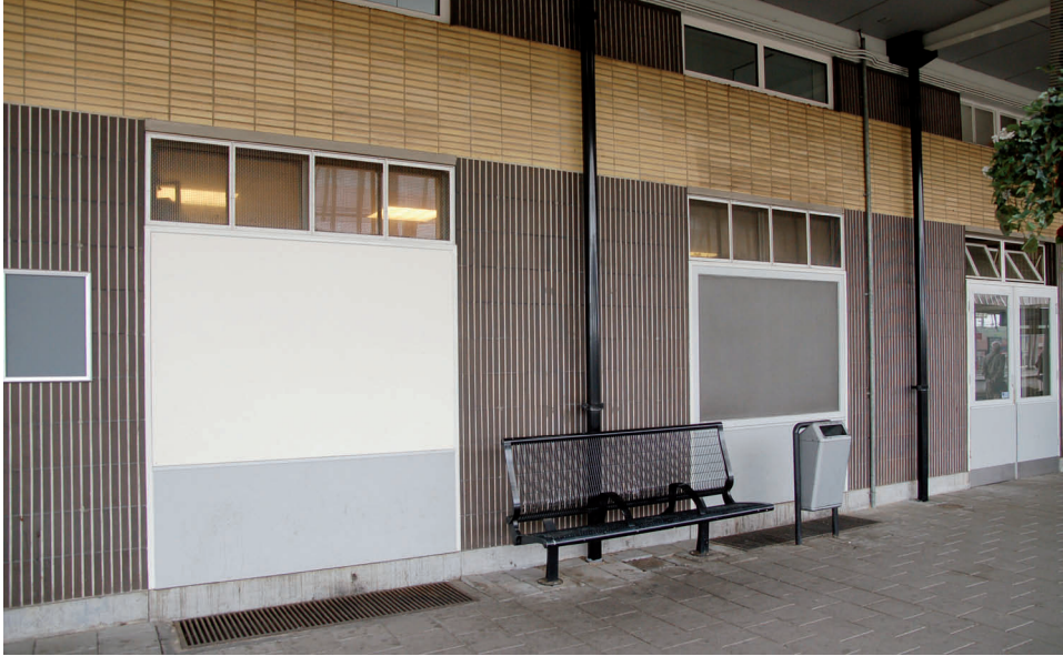
Steenstrips op de buitengevels, 2013
