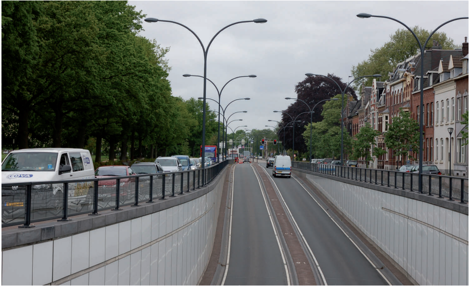
nieuwe verkeerstunnel onder Koninginneplein, 2013
