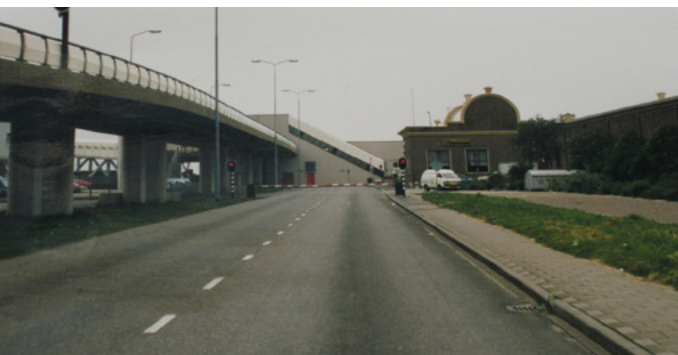
Het viaduct aan de oostelijke toegangsweg tot het veer ca 1990. Na de sluiting van het autoveer in 2003 afgebroken (BWT Vlissingen, panddossier Station)
