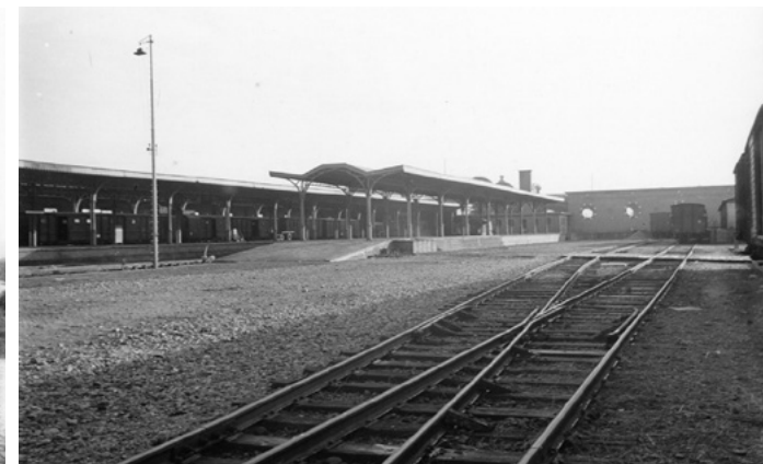
Zicht op het derde perron. Links de gevel van de fietsenstalling. De perronkap is opgebouwd uit gietijzeren kolommen in combinatie met metalen spantconstructie en houten dak. Bij het herstellen van de perronkappen handhaafde Van Ravesteyn de oorspronkelijke opzet. Foto c1 1950 (col. HUA)
