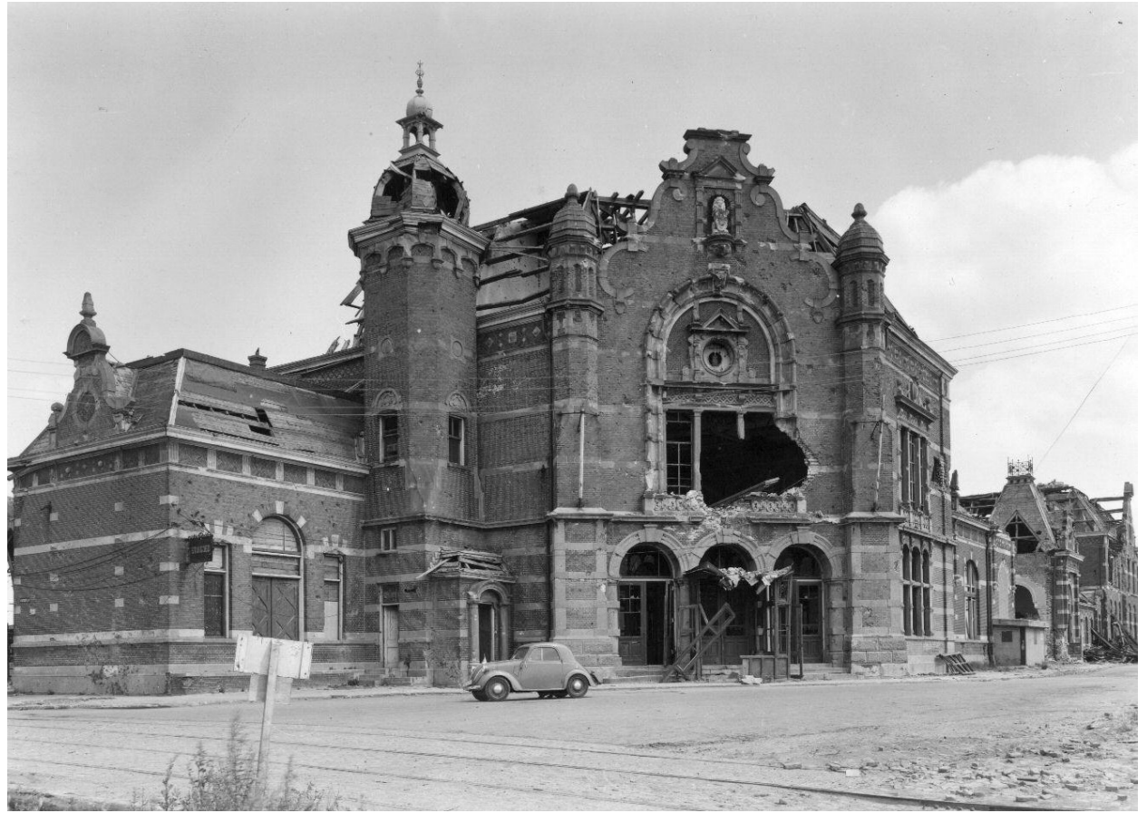
Het door oorlogsgeweld beschadigde stationsgebouw Vlissingen Haven in 1944. (col. HUA)
