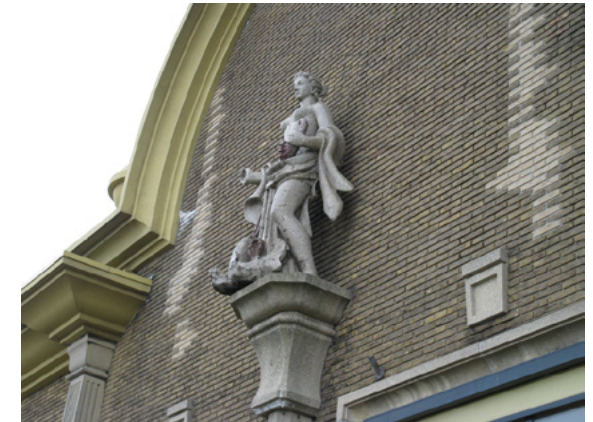
Gevel Station Vlissingen met hersteld gevelwerk. Kies bij onderhoud zoveel mogelijk voor reparaties met de oorspronkelijke materialen, 2013
