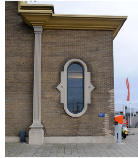
Onderdelen van de door Van Ravesteyn ontworpen rijke gevel: de accoladevormige sierstenen raamomlijsting, metalen kozijnen, pilasters van plint tot geprofileerde daklijst, baksteen, 2013
