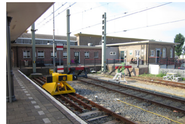
De gekoppelde dienstgebouwen, gevels spoorzijde, in 2013
