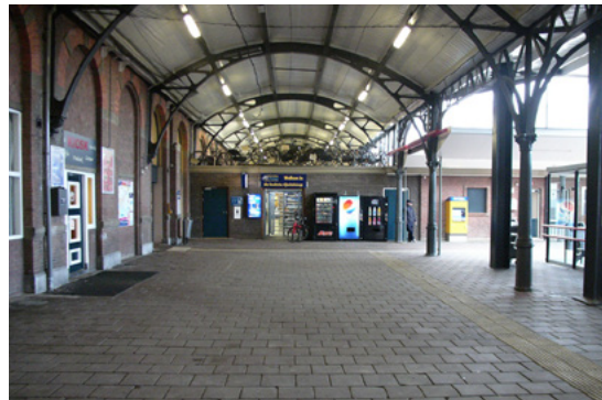
Verplaatste entree rijwielstalling, aan het perronplein, 2013
