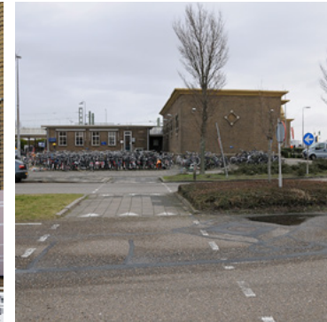
De westelijke kopgevel van de fietsenstalling, in 2013
