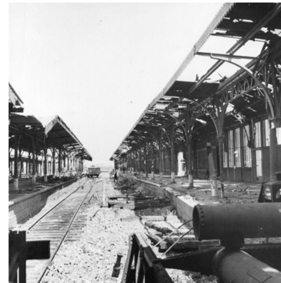
De beschadigde perronoverkapping, beschadigd en ontzet door het bombardement in 1944. De beschadigde kappen zijn na de oorlog hersteld (col. HUA)
