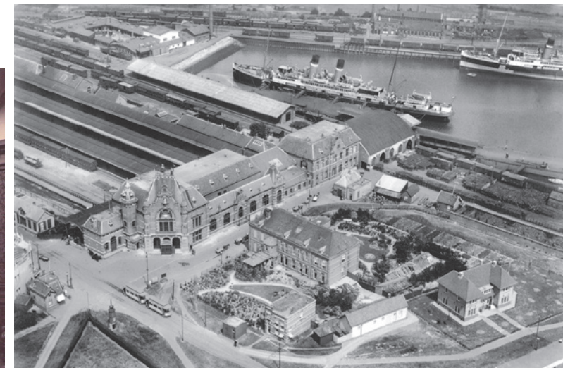
Luchtfoto van station Vlissingen Haven in 1924 (Meerman 1996, nr 2511)
