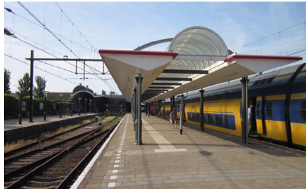
De aanhechting van de Van Heukelom kolommen aan de vernieuwde kap (1989) in stijl contrasterend, deze is 'losgehouden' van de nieuwe perronkap, juli 2013.
