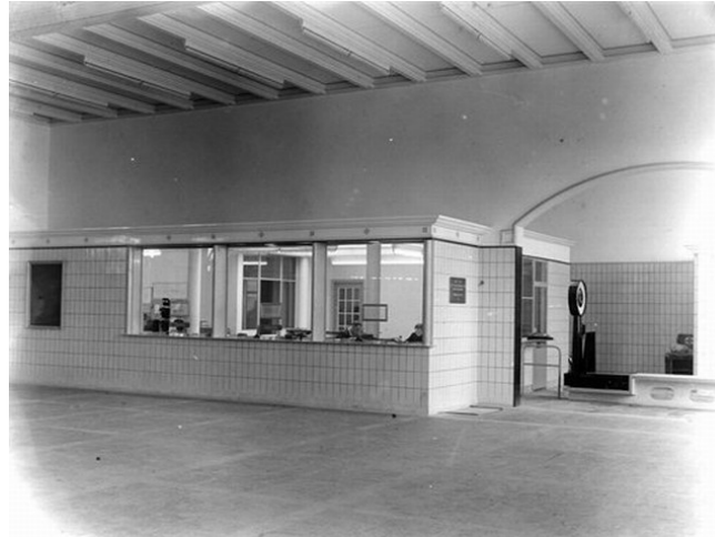
De ruimte voor de kaartverkoop (links) en de bagagebank (rechts) in de entreehal, tijdens de oplevering in 1950 (col HUA)
