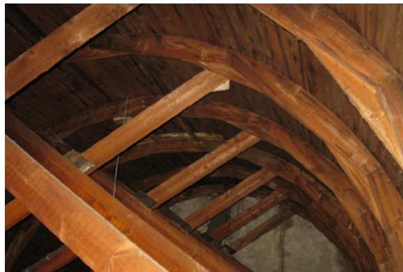
De houten hulpmstructuur van het gewelf, 2013
