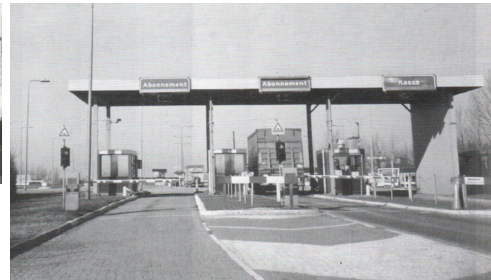
De oostelijke weg ontwikkelde zich vanaf 1950 als hoofdtoegangsroute tot de boot. Ongedateerd (voor de sluiting van het autoveer in 2003). (Dieleman, 2003, p. 65)
