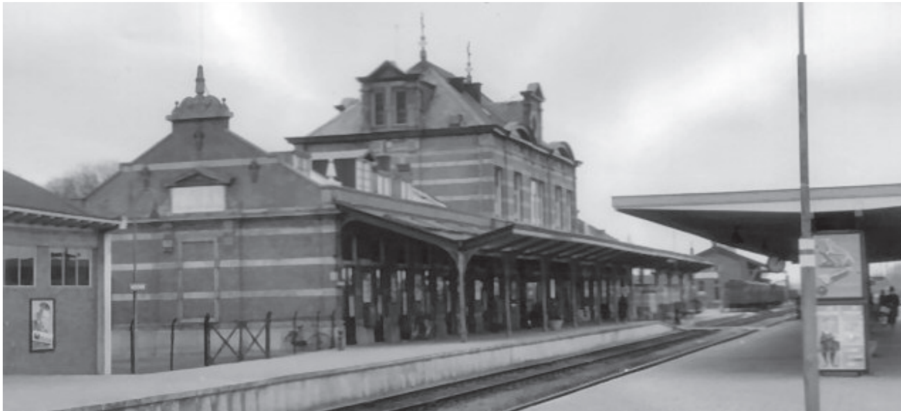
Station Hoorn, ca. 1960. De oorspronkelijke dakkapellen op het middendeel zijn nog aanwezig. [Stationsweb]
