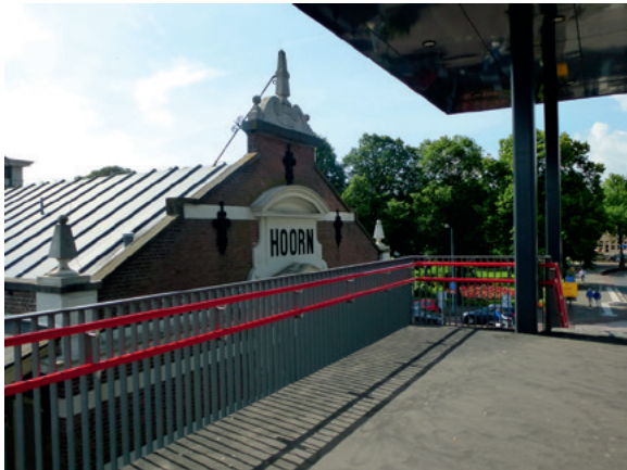
De overkapping van de voetgangersbrug domineert de westvleugel
