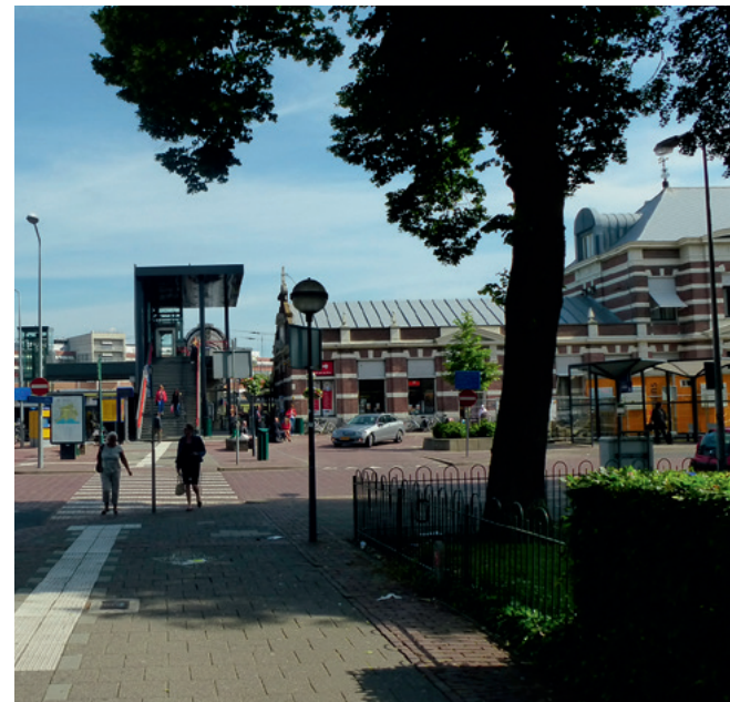
Links van het station de voetgangersbrug met de nieuwe overkapping, 2013.
