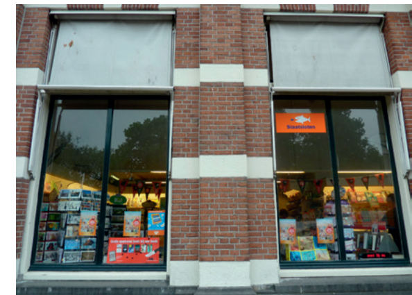
De raamkozijnen in de voorgevel zijn in oorspronkelijke toestand hersteld
