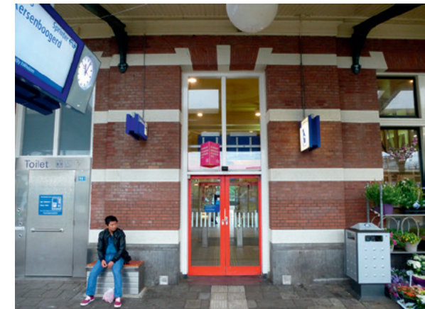
De toegang tot de stationshal vanaf de perronzijde. De automatische schuifdeuren zijn geplaatst bij de renovatie van 1990-1991.
