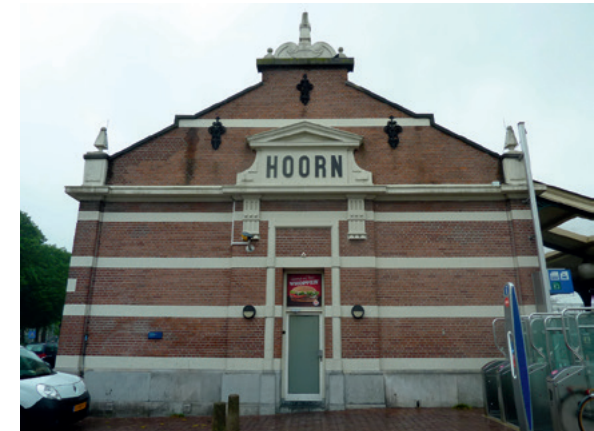
In de oostgevel is een nooddeur aangebracht
