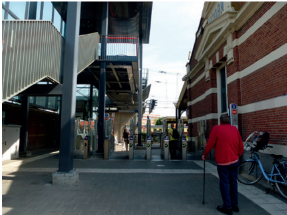
OV-poortjes voor de toegang tot de perrons aan de westzijde
