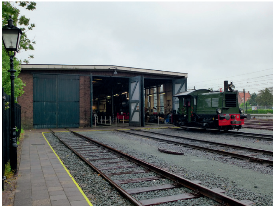
Diesellocomotievenloods, 2013. De loods is nu in gebruik door de Museumstroomtram Hoorn-Medemblik
