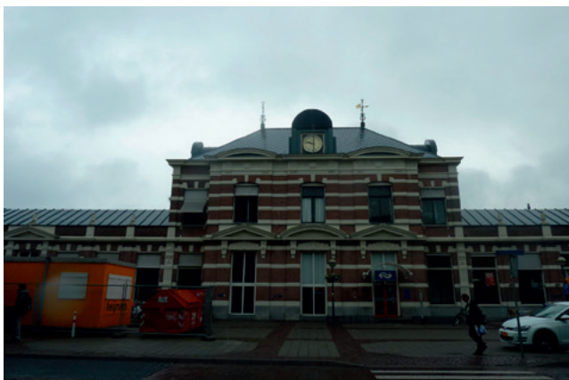
De toegang tot de stationshal is bij de renovatie in 1990-1991 verplaatst naar de oostdeur, waardoor de symmetrie doorbroken werd
