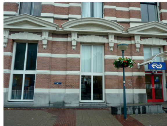
Twee toegangsdeuren in het middendeel zijn vervangen door ramen. Boven de toegang is een kunststof overkapping aangebracht
