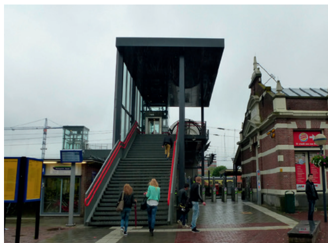
Voetgangersbrug met de nieuwe liftpartij en trapoverkapping, 2013
