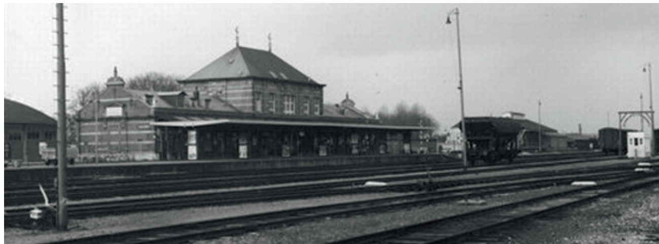
Station Hoorn, 1967. De dakkapellen op het middendeel zijn verwijderd [Stationsweb]
