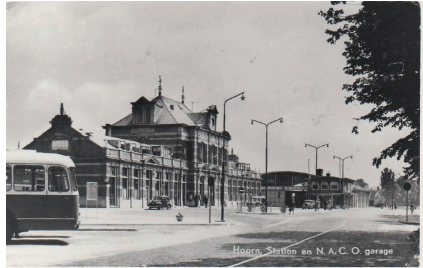
Het stationsplein met rechtsachter de busgarage (1953), 1958. [Stationsweb]
