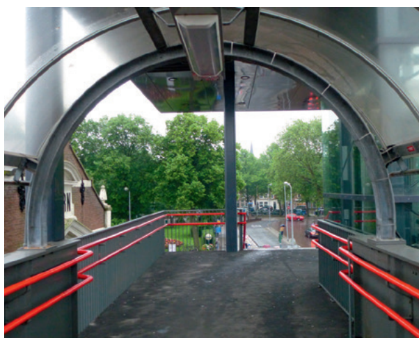
Overkapping van de voetgangersbrug uit 1989.
