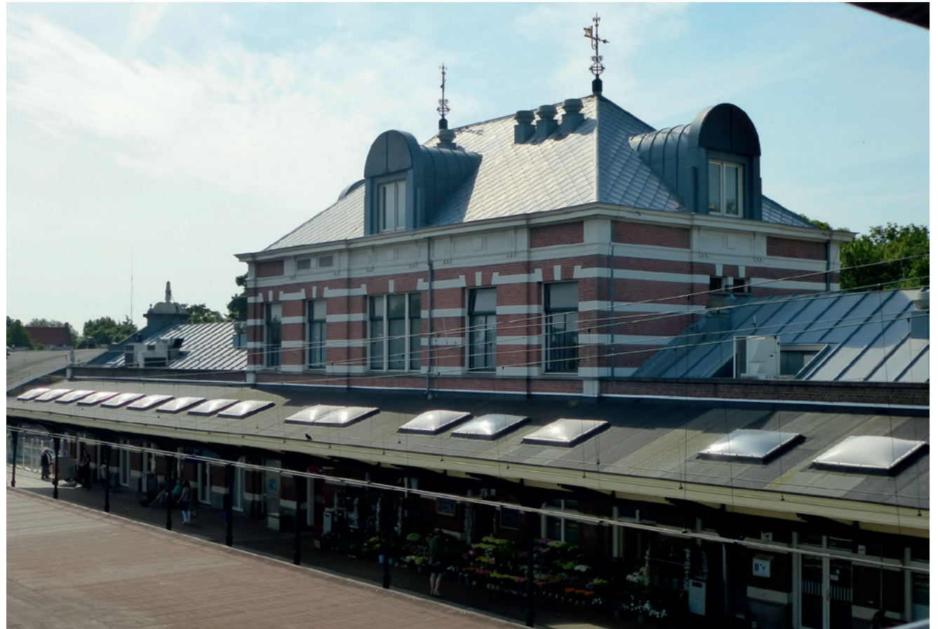
Perrongevel. De balkons voor de technische installaties, de schoorstenen op het middendeel en de bolvormige daklichten zijn later toegevoegd.
