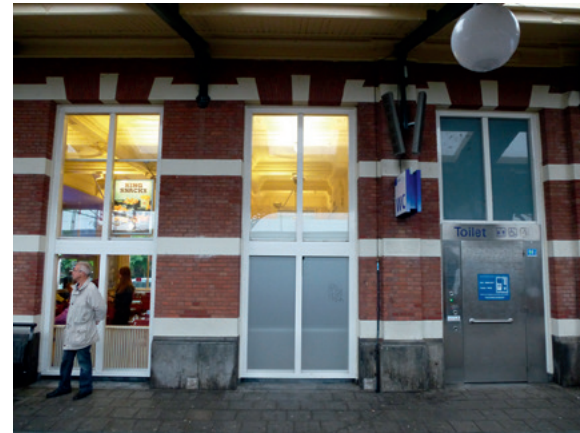
Perrongevel. De kozijnen en het toilet zijn niet oorspronkelijk
