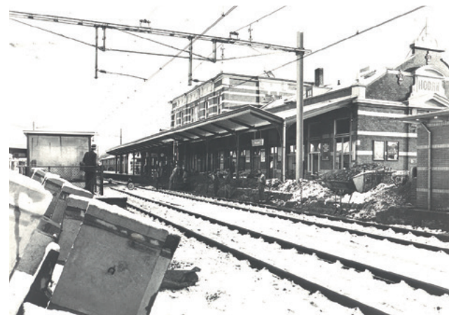
Werkzaamheden ten behoeve van het verlengen van de perrons, de aanleg van de voetgangersbrug en het verplaatsen van het overpad, 1981 [WFA]
