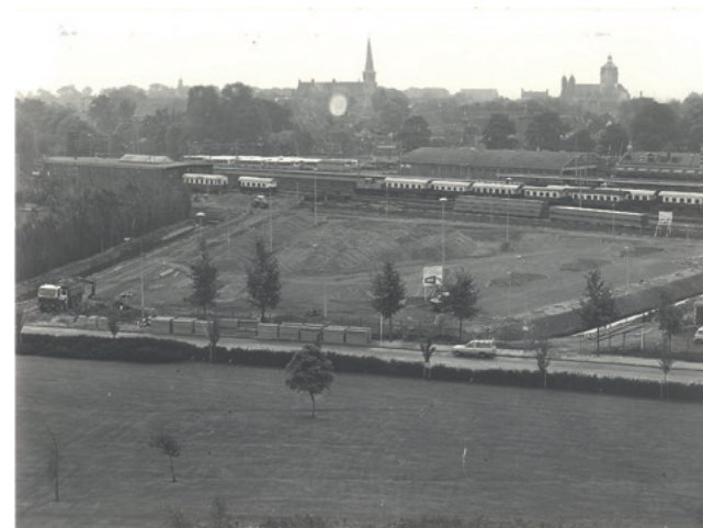
Werkzaamheden aan de noordzijde van het station ten behoeve van de aanleg van het parkeerterrein en de voetgangersbrug, 1981 [WFA]
