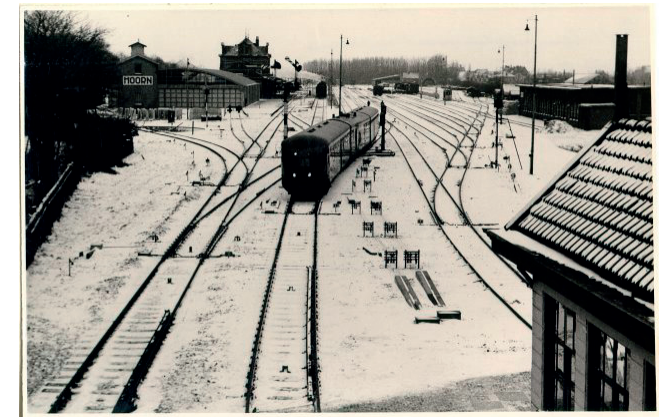
Emplacement, ca. 1955. Links de nieuwe bussenloods en het water-reservoir, rechts op de achtergrond de dieseltreinenloods uit 1929 [WFA]
