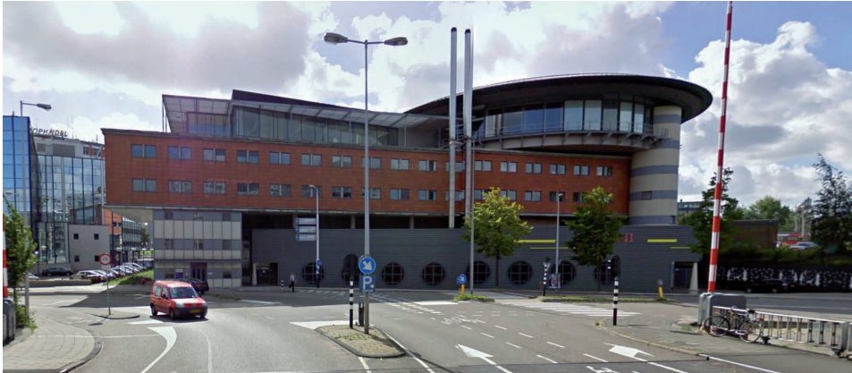
Centrale verkeersleidingsgebouw in Amsterdam, 1995
