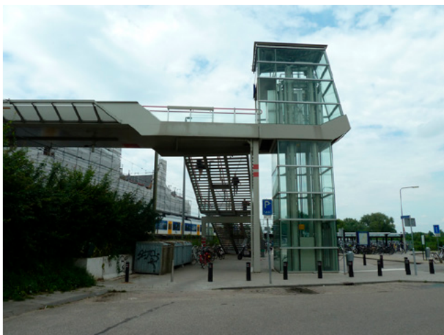
Toegang tot de traverse aan de oostzijde van het stationscomplex.
