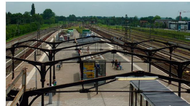
Perronoverkapping zonder dakbedekking, 2014.
