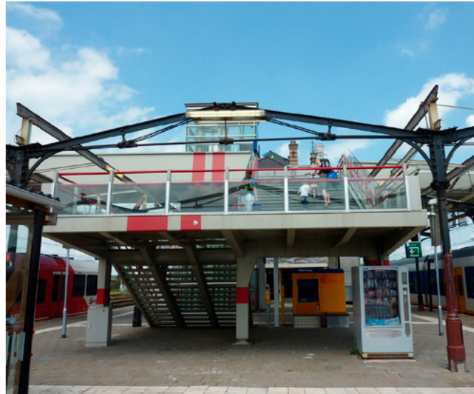
Zicht op de middentrap van de voetgangersbrug die door de perronkap steekt.
