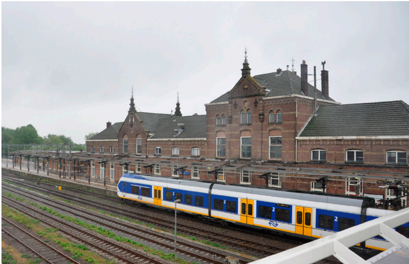
Westgevel van het hoofdgebouw vòòr de restauratie. [NS]
