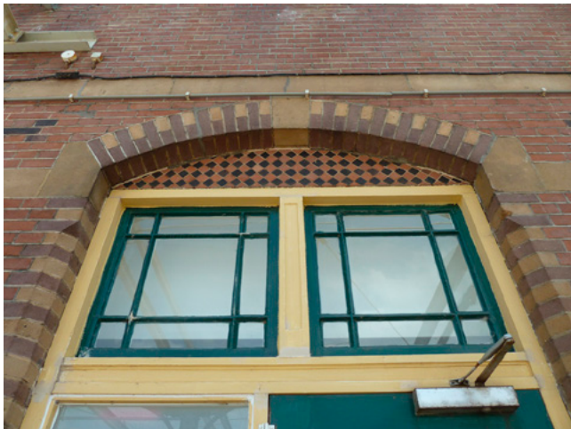
Oorspronkelijk siertegel- en metsenwerk (nevengebouw).
