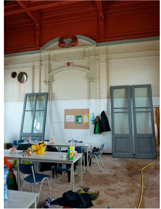
Voormalige wachtkamer eerste en tweede klasse. Ook hier is het originele plafond aanwezig evenals de muurdecoraties.
