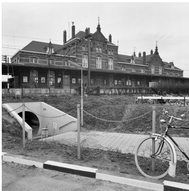
Ingang van het voetgangerstunnel ten oosten van het stationscomplex, 1974. [www.stationsweb.nl]
