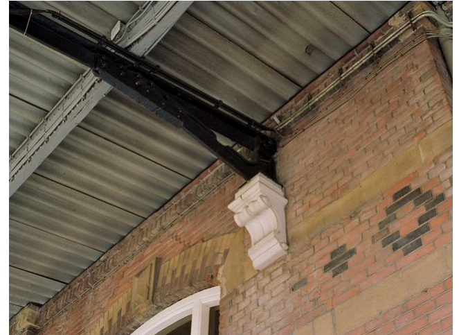
Verbinding perronkap en hoofdgebouw met console. [www.stationsweb.nl]
