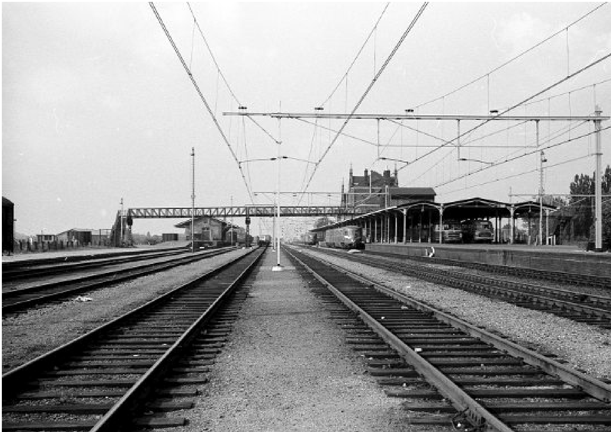
Het emplacement van station Geldermalsen in 1954, gezien vanuit het zuiden. [J.G.C. van de Meene]
