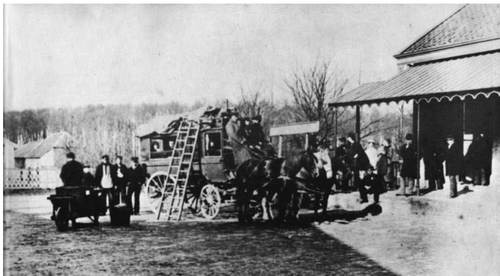
Stationsgebouw I Geldermalsen, gezien vanuit het Trichtsevoetpad, 1880. [www.stationsweb.nl]
