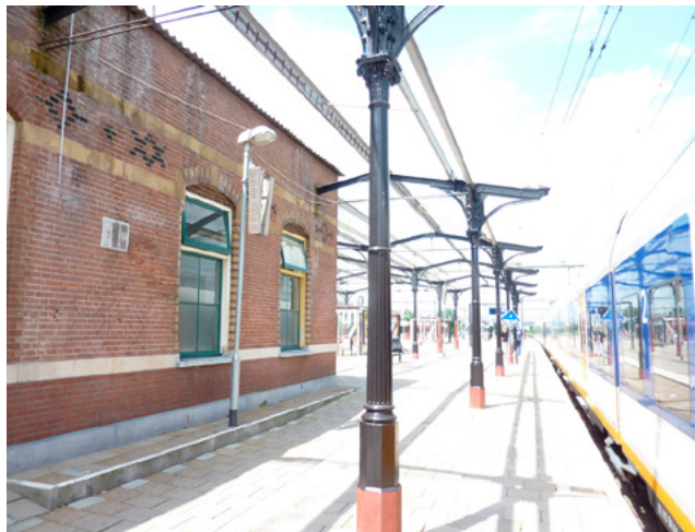
Nevengebouw, oostgevel in huidige staat.
