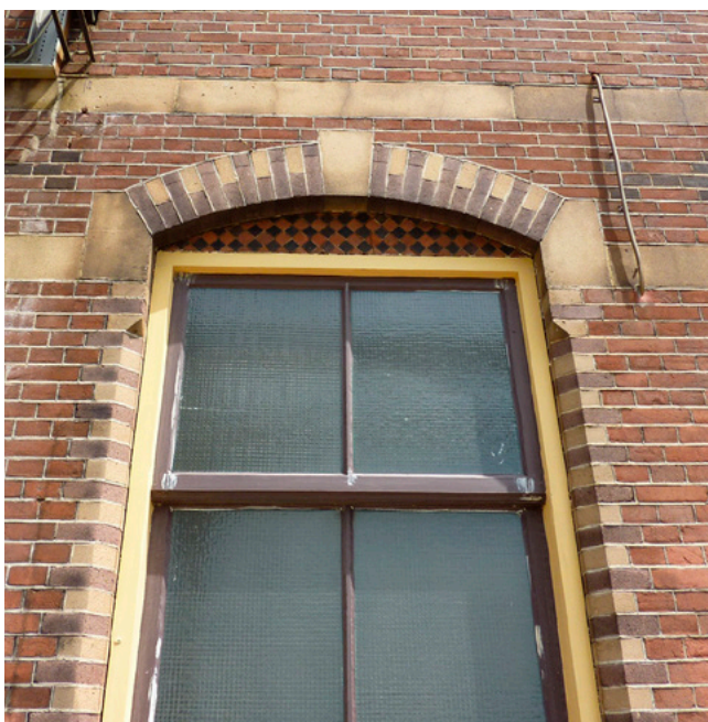
Siertegel- en metselwerk van het nevengebouw.
