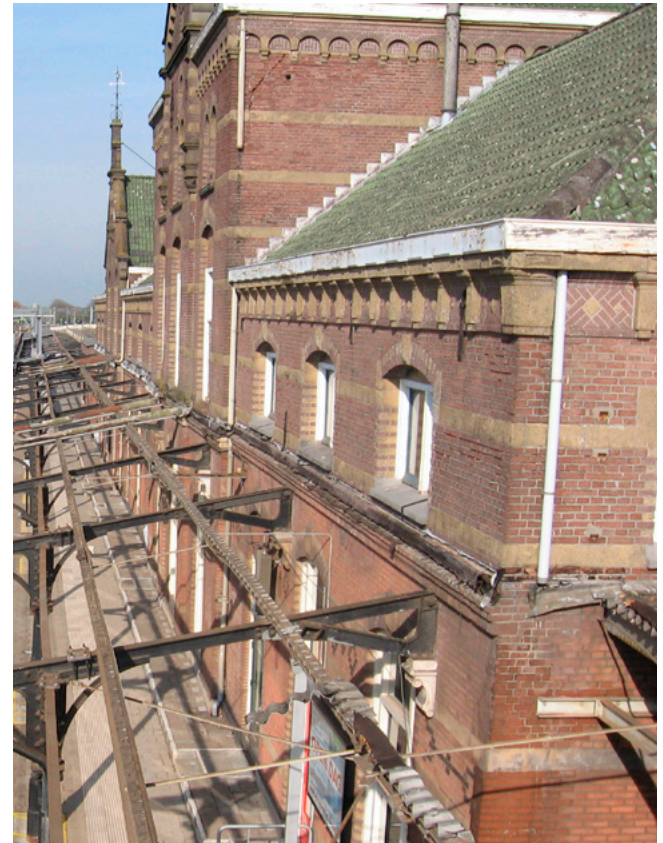
Hoek west- en zuidgevel vòòr de restauratie. [NS]
