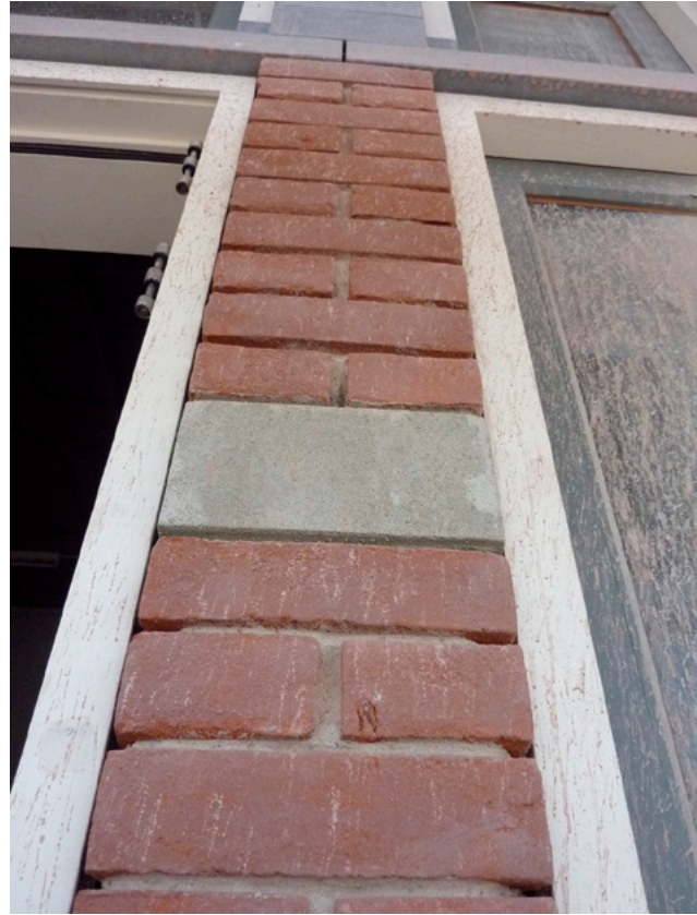
Herstel metselwerk en restauratie van het voegwerk.
