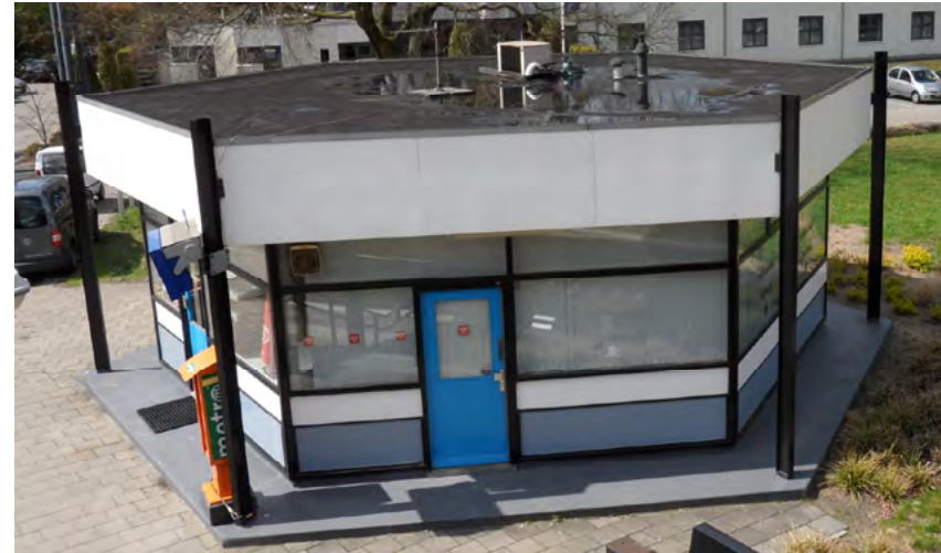
Afb. 4.10 Het dak met daklijst van sextant Bussum Zuid.
