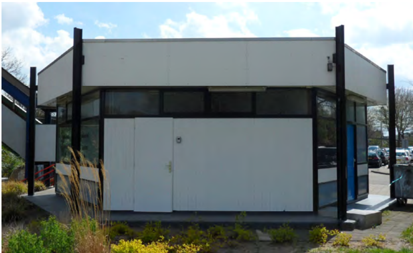
Afb. 4.14 De dichte wand met witgeschilderde schroten en bovenlichten van sextant Bussum Zuid. De plint onder de ramen is bij deze sextant lichtgrijs geschilderd.
