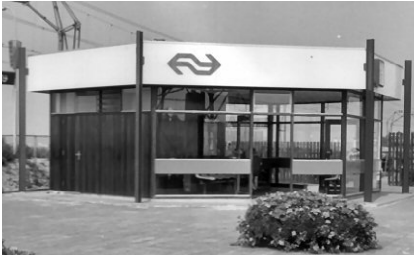
Afb. 4.1 Sextant te Maassluis West, met links de gesloten wand met schrootjesafwerking. Rechts de glaswanden, met ramen die ook onder de brede middenbalk doorlopen. Het gebouw oogt zeer transparant. Foto 1970
