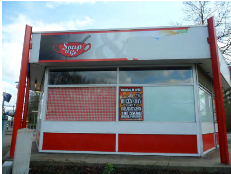
Afb. 4.25 De afgesloten raampartijen in de sextant te Diemen, tijdelijk met rolgordijnen (links) en permanent met plakplastic (rechts).
