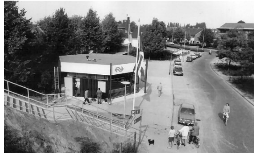
Afb. 4.3 Sextant te Eindhoven Beukenlaan in de originele bouwkundige situatie. Door NS-logo en kleurstelling is de link met het hogerliggende emplacement voor reiziger zichtbaar. Detail van foto, 1971
