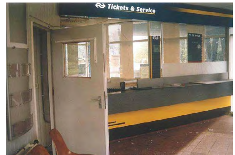
Afb. 4.22 Vloerbekleding met rechthoekige tegels in de inmiddels gesloopte sextant van Delft Zuid. De Emalitplaat onder de balie is bij een latere verbouwing vervangen door een standaard NS-balie-inrichting. Foto 2004
