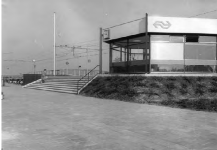
Afb. 2.25 Station Haren in 1969. De brede trap en de hoger gelegen sextant vormen samen het gezicht van het station.
