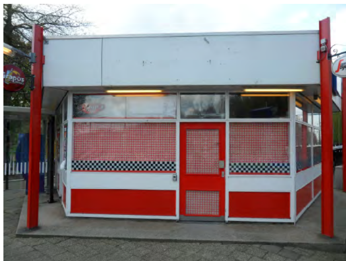
Afb. 4.13 TL-verlichting onder de dakrand bij station Diemen.
