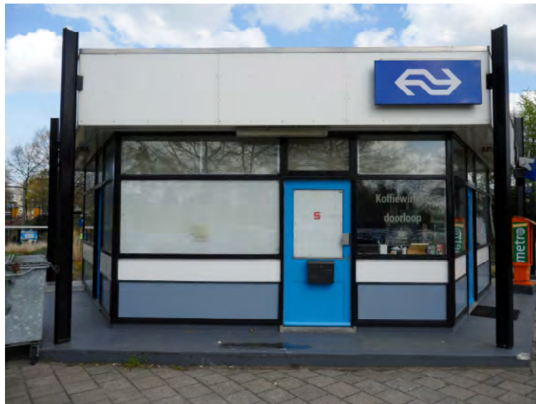
Afb. 4.26 Recent (na 2009) zijn enkele raampartijen in de voormalige wachtruimte van Bussum Zuid permanent afgesloten met boardplaten.
