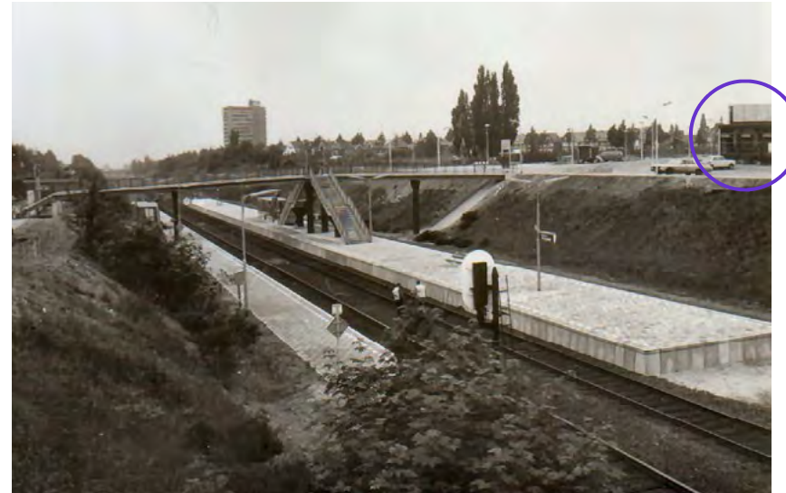
Afb. 2.20 Het grote hoogteverschil op station Nijmegen Heyendaal. In het midden verdiept de spoorbaan met perrons. Rechtsboven de sextant en parkeerplaats. Foto 1970
