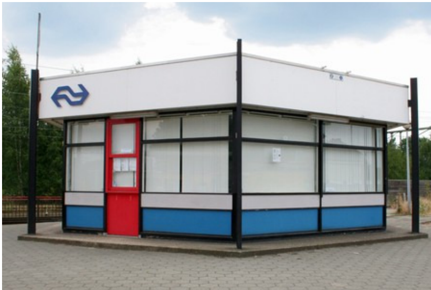
Afb. 4.2 Sextant te Susteren, met de huidige geschilderde plinten van boardplaat, ter vervanging van de glazen 'plint'. Foto 2009
