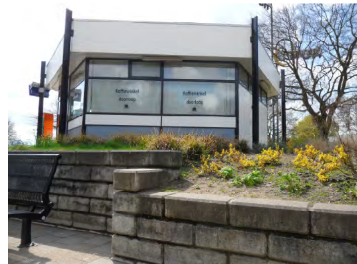
Afb. 2.29 De huidige stapelmuurtjes van betonblokken te Bussum Zuid.
